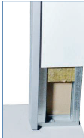
Ausführung F: Bodenanschluss für Estrich
